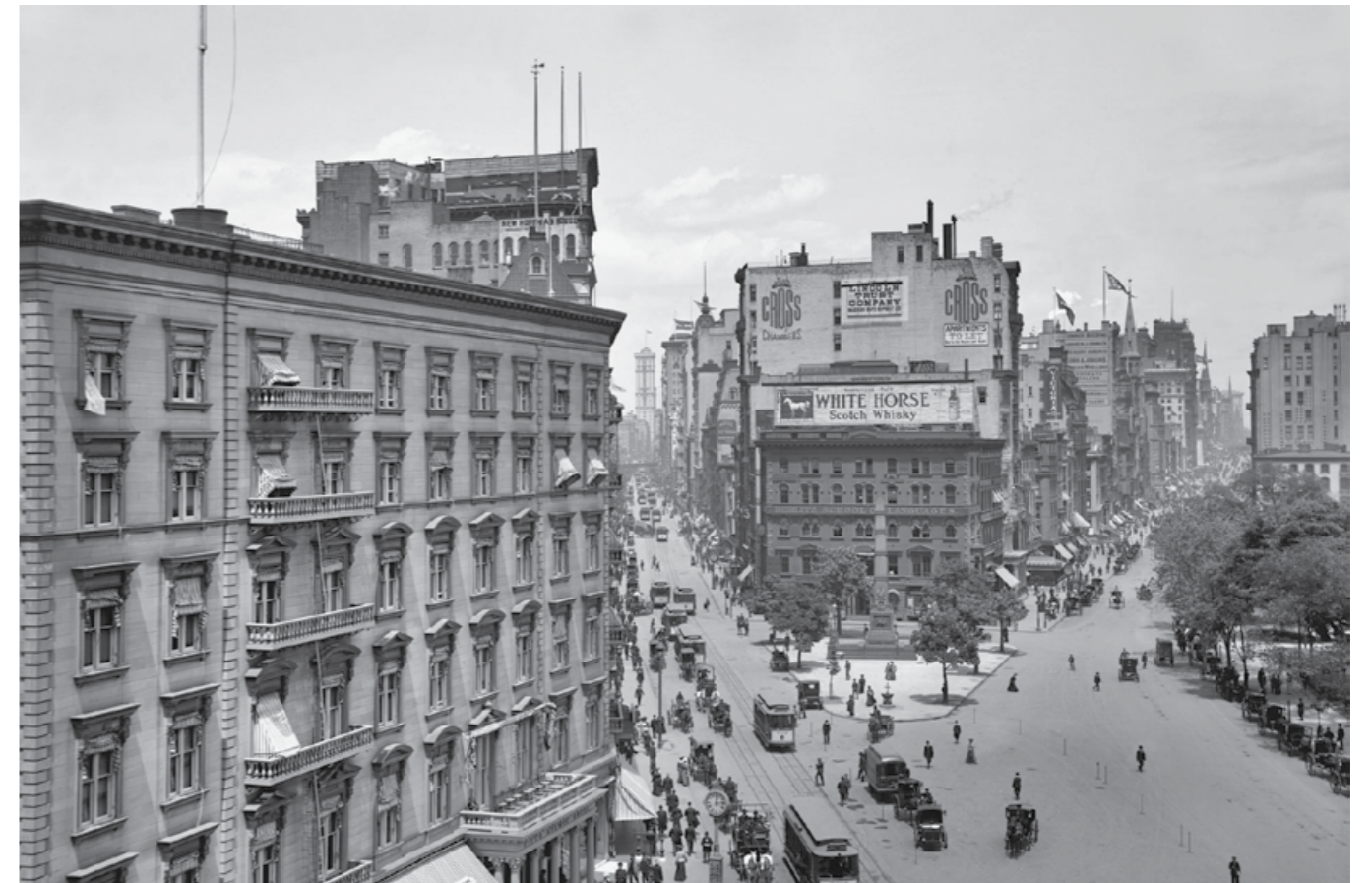
NUEVA YORK Vistas del Distrito en el siglo XX / NEW YORK District overlooking the XX Century.
